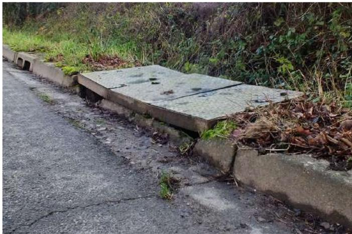
Les **avaloirs**, ce sont ces ouvertures que l'on voit au bord des caniveaux et qui récupèrent l'eau de pluie qui coulent le long des trottoirs... Ils permettent à cette eau de rejoindre les drains d'eau pluviale qui circulent sous la chaussée et qui conduisent cette eau vers un exutoire, en général (à Ugny le Gay), à un des ruisseaux qui coule dans le village...
