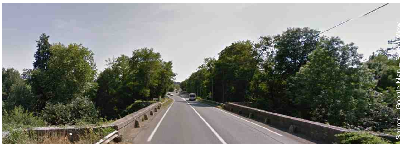
figure 79 : pont sur la Vonne, RD611 à la sortie Nord de Lusignan
