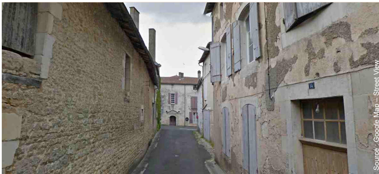
figure 10 : une potentielle zone de rencontre : la rue du temple. Civray.
